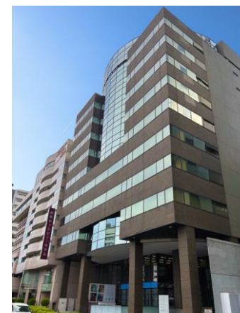
プライム新横浜ビル
